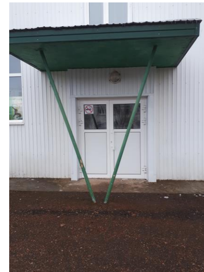
Фото 4 Входная площадка (перед дверью)
