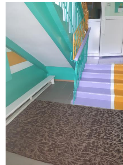
Фото 8 коридор (зона ожидания)
