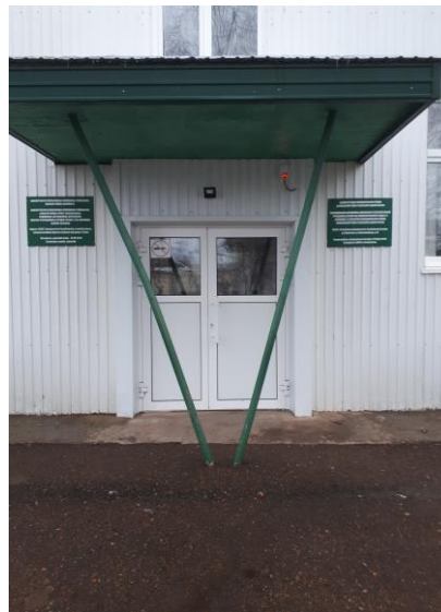
Фото 3 Входная площадка (перед дверью)
