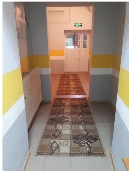
Фото 10 коридор (зона ожидания)
